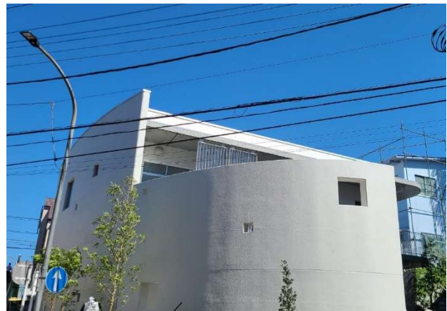
完成した新園舎外観
